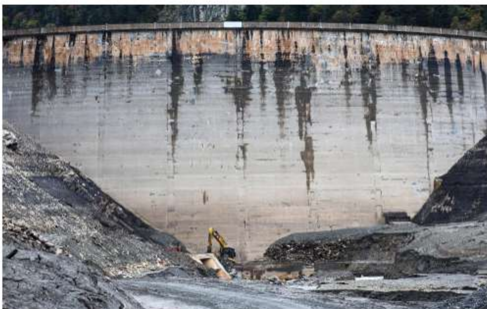
Le barrage est vidé back-to-back des deux côtés pour permettre les travaux qui se déroulent sous l'eau, par exemple. © Crédit photo : David Le Dantec/SUD OUEST
